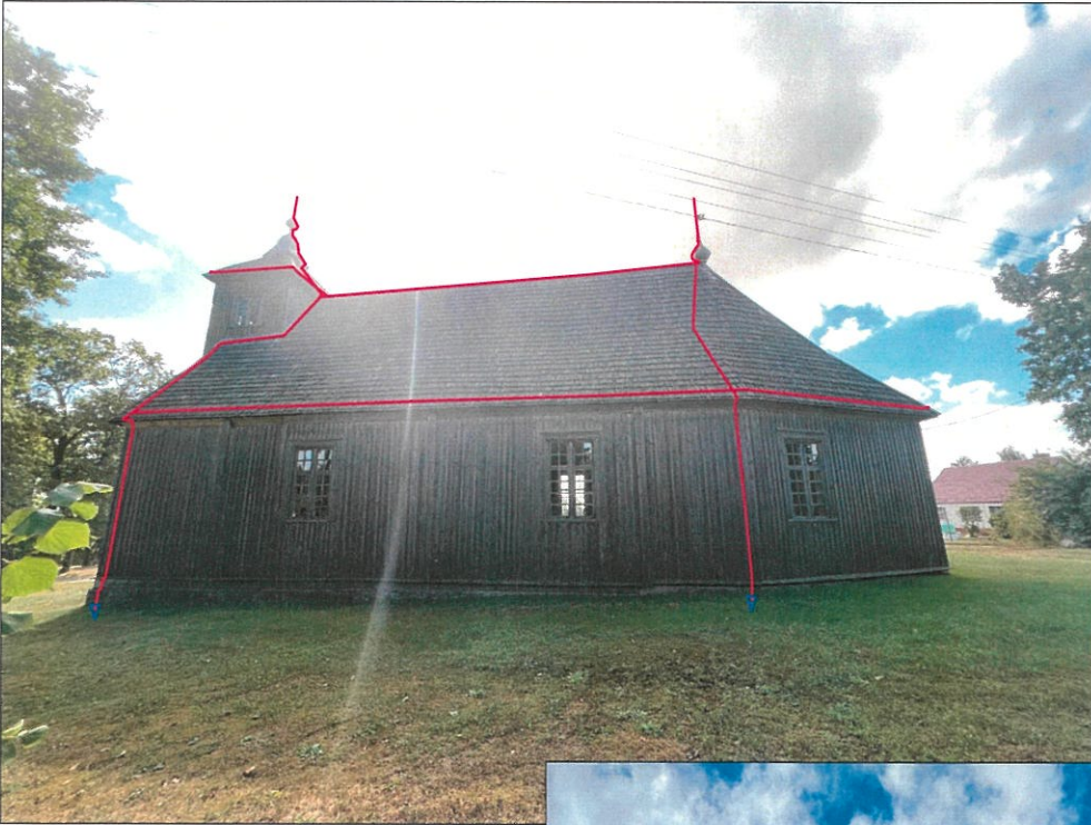
Foto Nr.3 (Š fasadas)
